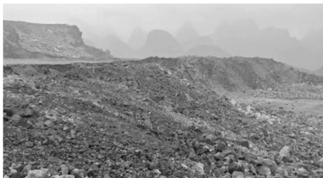
图11 RTK线放样布孔法爆破效果
