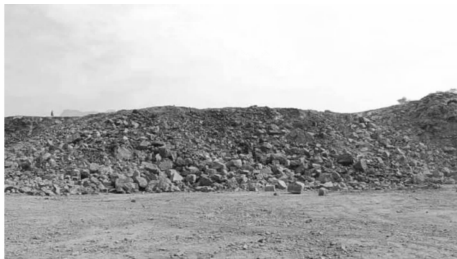
图10 皮尺布孔法爆破效果
