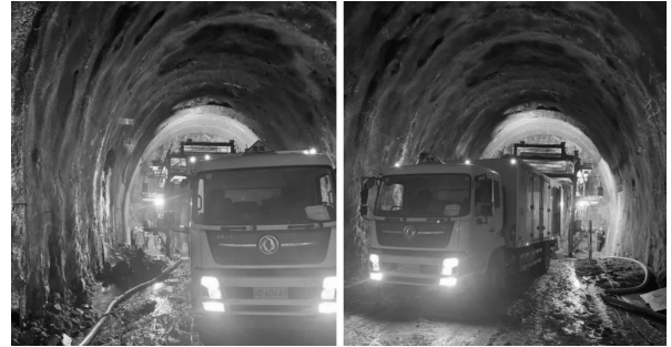
图2 现场混装炸药装药施工图
