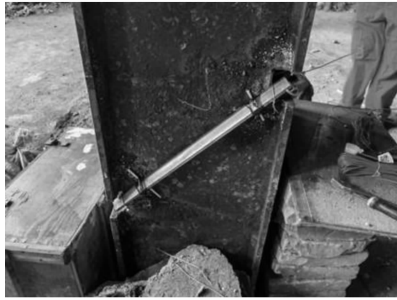
图5 切割器设置示意图(单位:mm)
