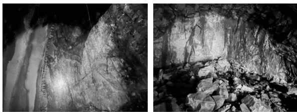
(a) 爆破后断面 (b) 爆堆 (a) Blasted section (b) Blast pile
