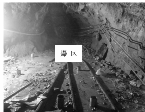
图1 爆破试验探洞
