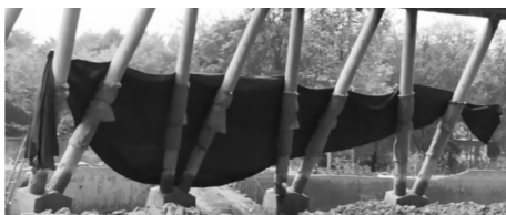
图5 立柱爆破近体防护结构示意图
