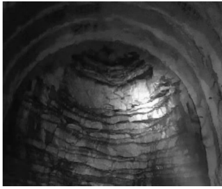
图8 现场爆破效果
