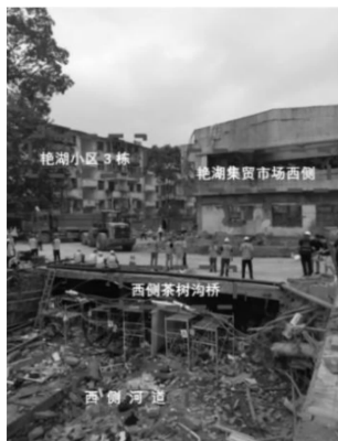
图 4 集贸市场西侧破坏情况
