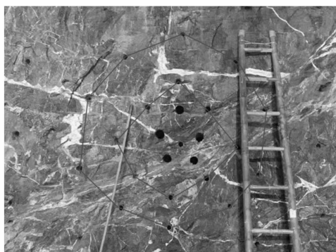
图4 优化前的掏槽眼孔网参数(单位:cm)
