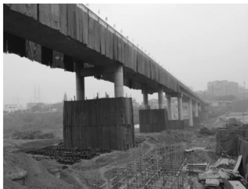
图6 爆破飞石防护措施
