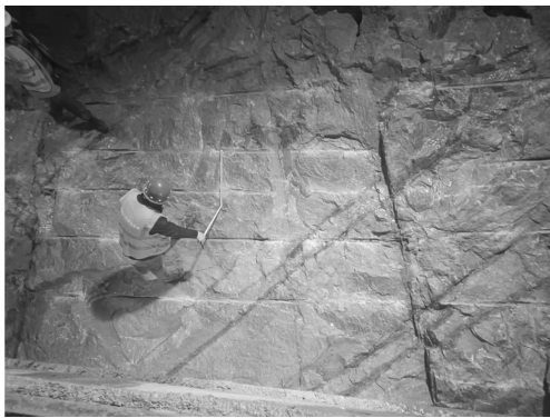
图8 仰拱光面爆破效果
