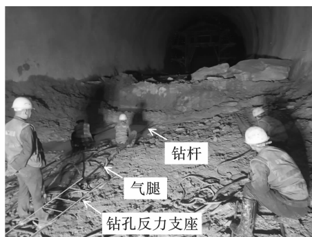
图6 周边孔钻孔
