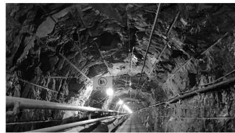
图5 周边空孔光面爆破后现场拍摄
