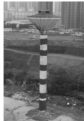
图1 倒锥形钢筋混凝土水塔
