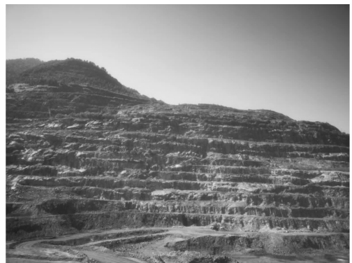
图1 西帮边坡现状
