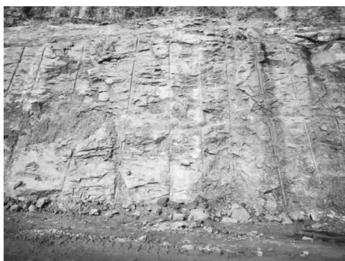
图7 装药结构优化爆破效果
