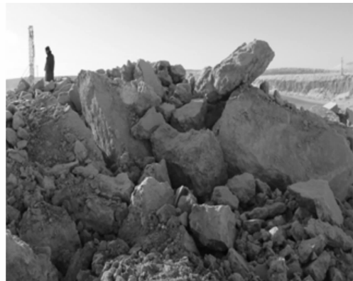
图2 冻土层爆破后大块
