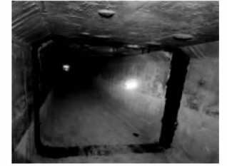
伸缩缝渗漏修复后
