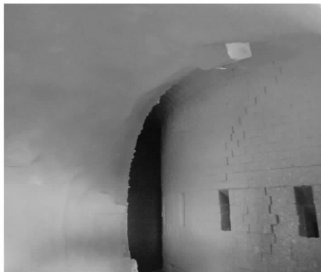
图 4 塌砖喷涂修复效果图
