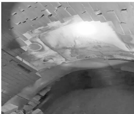
图 2 煤气入口管道塌砖情况
