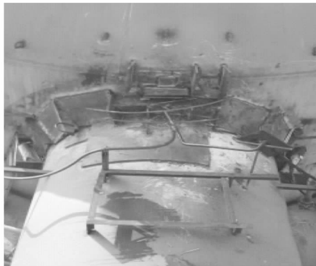
图 1 3 号热风炉燃烧器煤气入口现状
