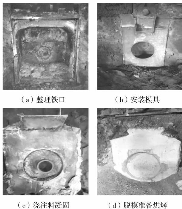
图4 泥套在实际生产中的制作过程
