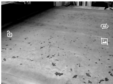
图 1 钢板上脱落的氧化铁皮
