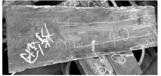
图 1 腹板裂纹宏观形貌
